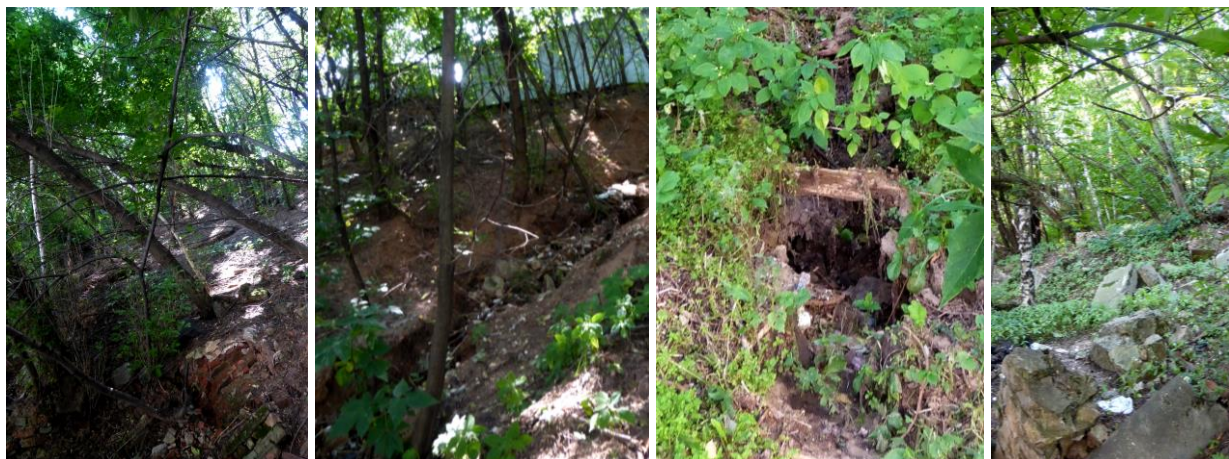
Рисунок 45 Участок склона, осложненный эрозионными бороздами, рытвинами и промоинами. Растительный покров образован насаждениями клена ясенелистного (часть деревьев имеют аварийный наклон ствола), травянистый покров практически отсутствует, поверхность сложена техногенными грунтами с обильным включением строительного мусора
